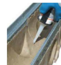
Pour rendre étanche le jointolement de deux caniveaux, déposez un ruban de type silicone au pistolet dans la gorge du caniveau.
