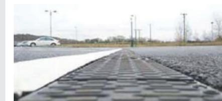
Les surfaces finies doivent être réalisées en prenant les précautions suivantes : la surface de roulement doit être surélevée de 3 à 5 mm par rapport à la surface des grilles. Les pierres accumulées en phase chantier doivent être enlevées des grilles avant utilisation des engins de compactage.
