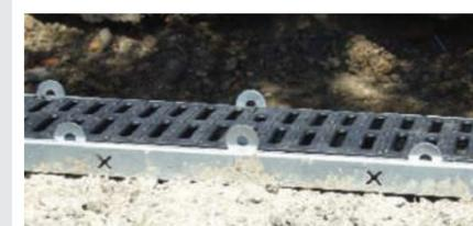
Durant la phase de coulée du béton, veillez à lester le caniveau à l'aide de barres de fer ou autres matériaux afin de stabiliser le caniveau. La grille doit être installée pendant la phase de coulée.
