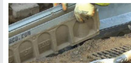
En partant de l'exutoire du réseau, connecter les caniveaux en suivant le sens de la flèche d'écoulement des fluides. L'assemblage de deux caniveaux se fait par emboîtement de type « mâle/femelle ». Durant la phase d'installation, le béton ne doit pas venir gêner le montage.
