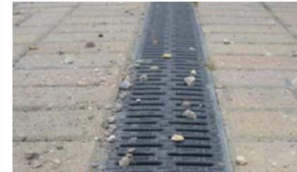
Les fentes des grilles doivent être inspectées visuellement. Les graviers accumulés doivent être retirés afin d'éviter une détérioration prématurée du caniveau et de sa grille. En effet, les graviers ou les pierres génèrent un point de concentration des charges au passage des roues. Ceci impacte la résistance de la grille et du caniveau. Il est à noter qu'en cas de détérioration due à ce point de maintenance négligé, les caniveaux et grilles sont à remplacer afin d'éviter tout accident.
