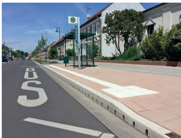
Accès facile à l'autobus grâce au trottoir surélevé de 18cm.
